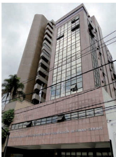
Edifício-sede da Reitoria do Instituto Federal de Educação, Ciência e Tecnologia de Minas Gerais.
